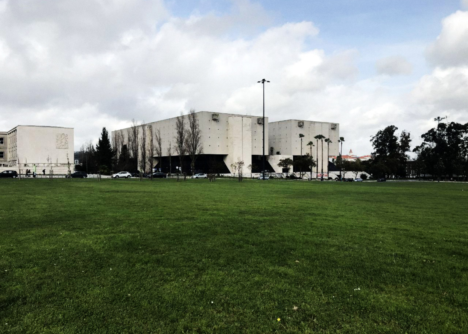
Внешний вид здания Национальных Архивов в Лиссабоне
