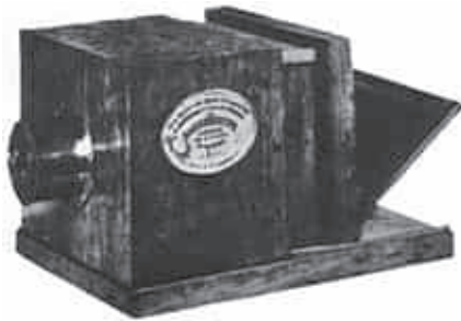
Оригинальная камера Дагера, сделанная Альфонсом Жиру
